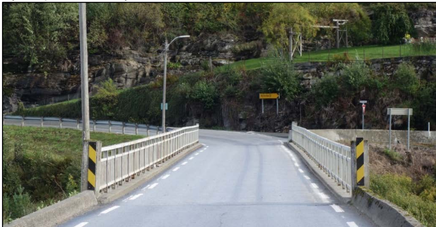
Figur 3: Storebrua går over Gloppeelva. Brua er bygd i 1939. Foto: SVV
