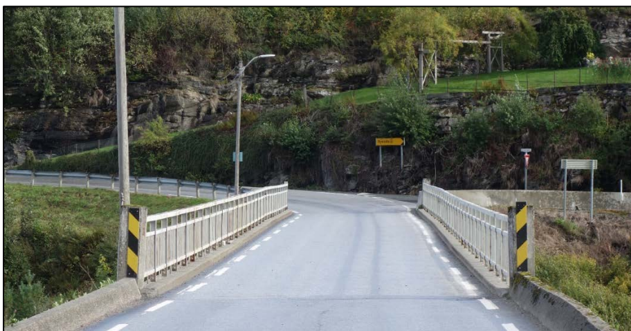
Figur 6: Storebrua går over Gloppeelva. Brua er bygd i 1939. Foto: Statens vegvesen
